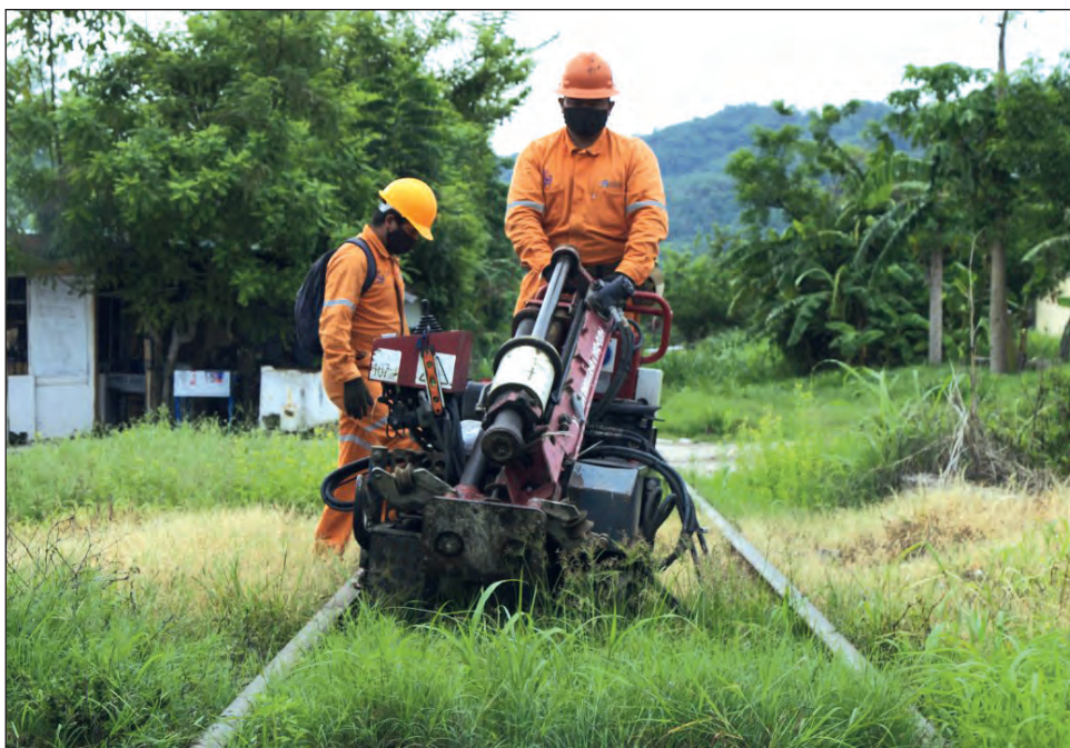
Las obras se realizan en zonas ya impactadas en derecho de vía existente, donde se cuenta con permiso de la Semarnat. Foto Fonatur
