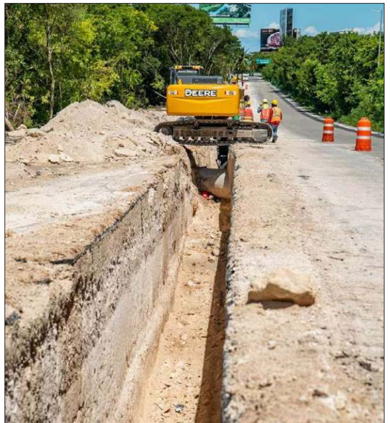
Las obras se llevarán a cabo de marzo a septiembre de 2025 e incluirán la renovación de más de mil 550 metros de tubería de 18 pulgadas. Foto Aguakan
