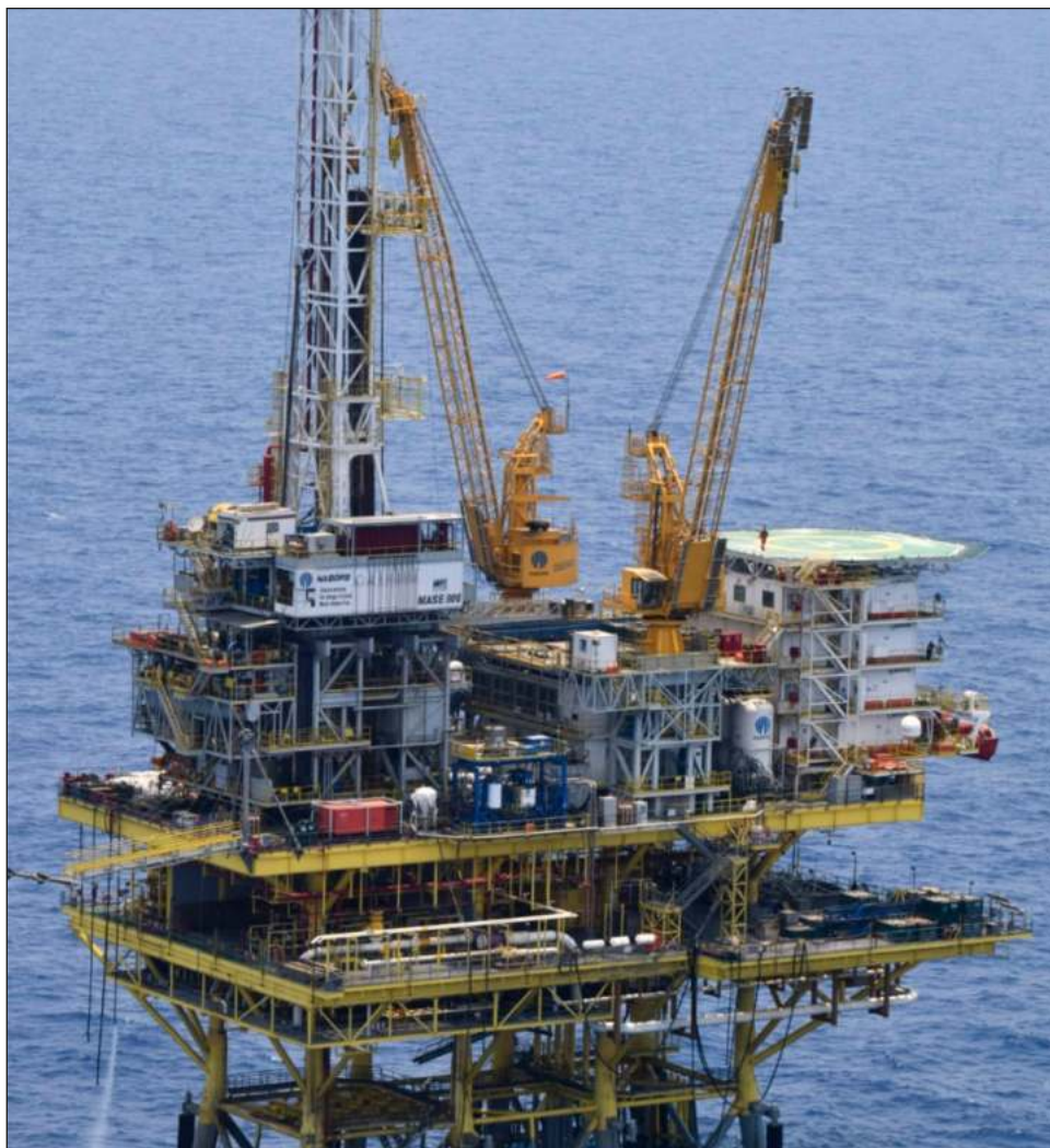
▲ La CMIC subrayó que es urgente que Pemex libere recursos para el mantenimiento de sus instalaciones marinas, no sólo para exploración y explotación de los pozos. Foto Twitter @Pemex
