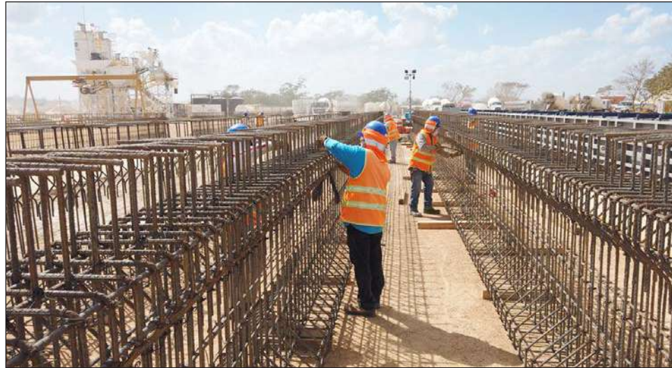
▲ Los aditamentos de la fábrica de ICA se emplearán en el tramo 4, Izamal- Cancún. Foto Fonatur
