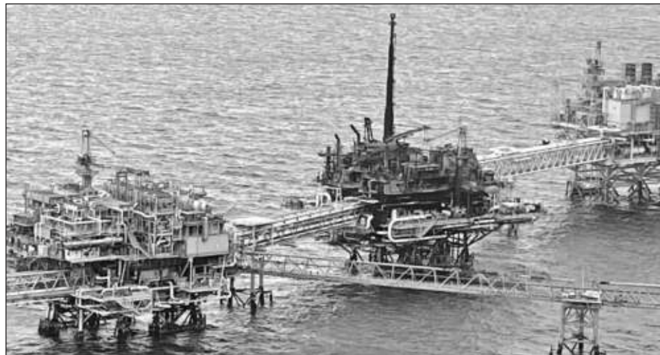
▲ Cerca de las 9 horas de este domingo, personal del área de seguridad detectó la presencia de gas en las instalaciones, por lo que fueron evacuados 130 trabajadores. Foto @pemex
