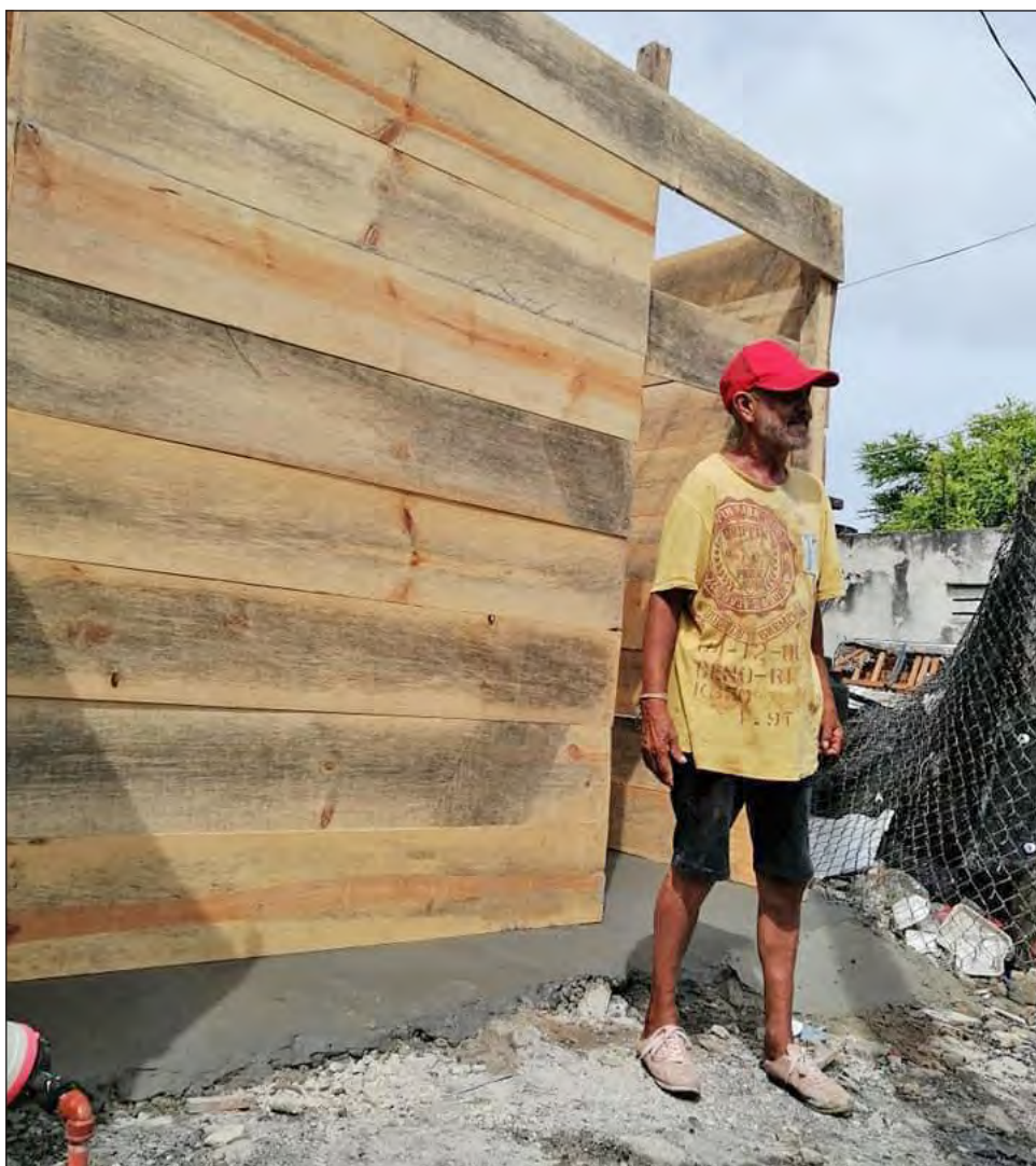
▲ La casita endeble a las lluvias de lámina y cartón que habitaba José Adán fue transformada en una casa de madera. Foto Joel Zamora
