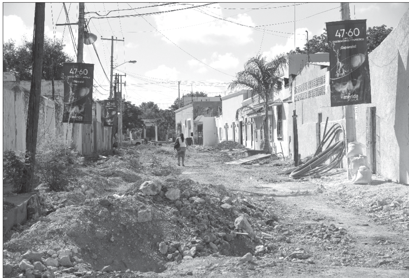
▲ Obra permitirá enlazar turísticamente al Gran Parque de la Plancha con el Corredor de la calle 47. Foto David Rico
