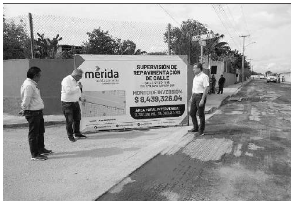
▲ La calle 127 de la 54 a la 96 de la colonia Emiliano Zapata Sur se caracteriza por ser vía importante de conexión de múltiples servicios para la zona. Foto ayuntamiento de Mérida
