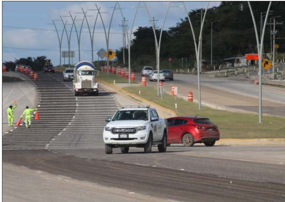
▲ De acuerdo con Eduardo Juan Guerrero Valdez, director de la Secretaría de Infraestructura, Comunicaciones y Transportes en Campeche, en las entradas a los fraccionamientos Siglo XXI y Ex Hacienda Kalá deberían existir sendos puentes a desnivel. Foto Fernando Eloy
