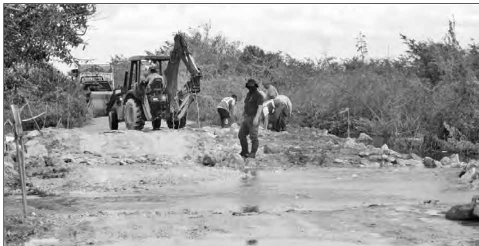
▲ La Secretaría de Obras Públicas se encarga de habilitar varias carreteras para rehabilitar la comunicación entre poblados afectados por las lluvias. Foto Gobierno de Yucatán
