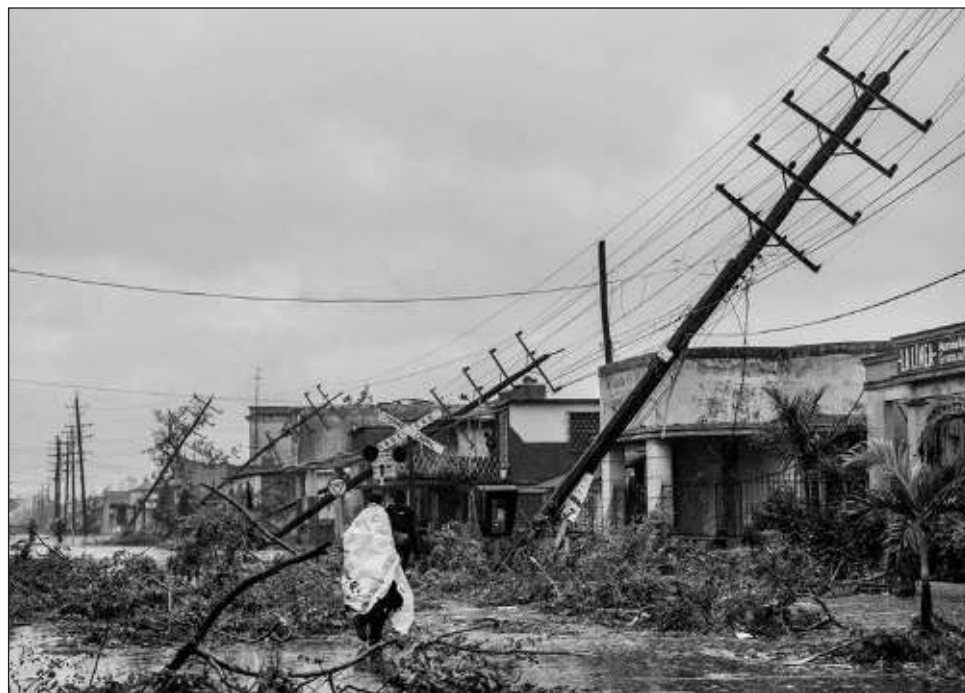
▲ El huracán Ian provocó que, por primera vez, la isla de Cuba se quedara completamente sin energía eléctrica en todo su territorio; la luz ha vuelto paulatinamente. Foto Ap
