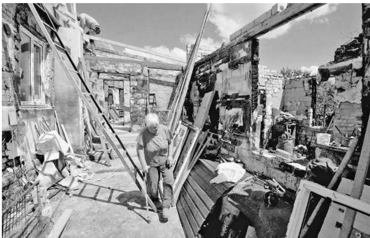
Una mujer camina cerca de su casa, cuyo techo es reparado por voluntarios, después de haber sido destruido por los bombardeos en el pueblo de Zalissyia, región de Kyiv, el 22 de julio de 2022, en medio de la invasión rusa a Ucrania. Foto: AFP/ Sergei Chuzavkov.
