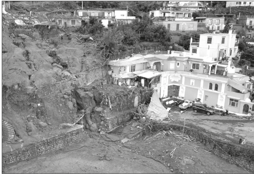
▲ Este sábado, las lluvias excepcionales produjeron un gigantesco alud en la ciudad de Casamicciola, el cual hizo colapsar edificios y arrastró vehículos al mar. Foto Ap
