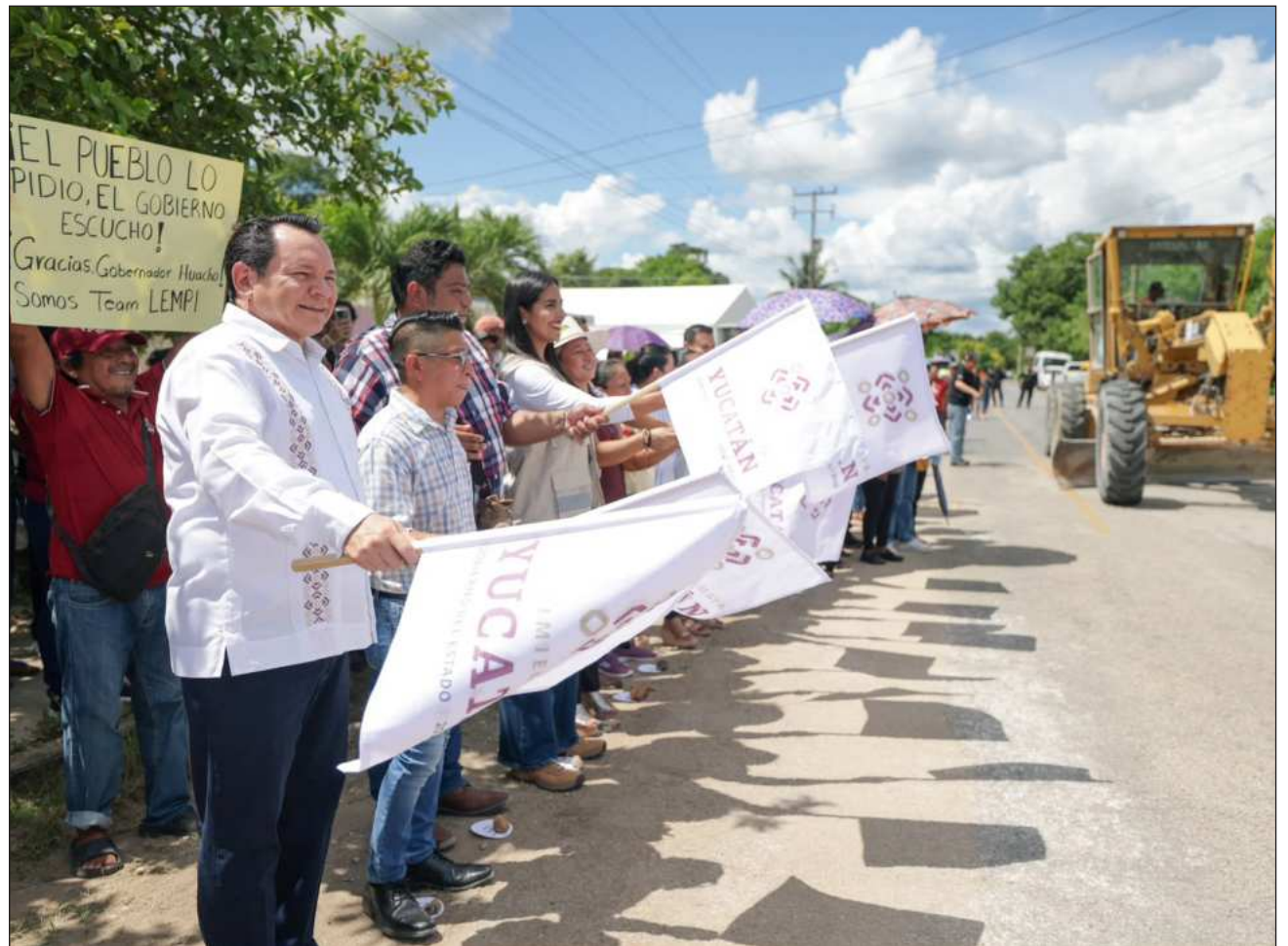
▲ El gobernador dio inicio a los trabajos, que abarcarán 5.8 km y una superficie de 34 mil 800 metros cuadrados. Foto gobierno de Yucatán
