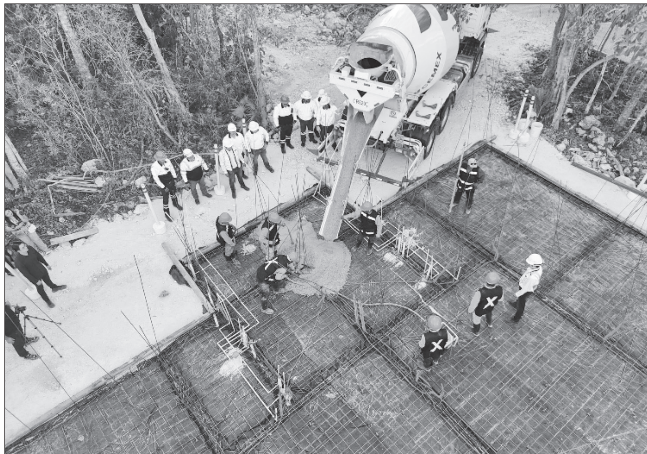
▲ Como parte del programa Vivienda para el Bienestar, la presidenta Claudia Sheinbaum encabezó el arranque de obras para la construcción de 26 mil nuevos hogares en Campeche y dio a conocer importantes obras para la entidad. Foto Presidencia
