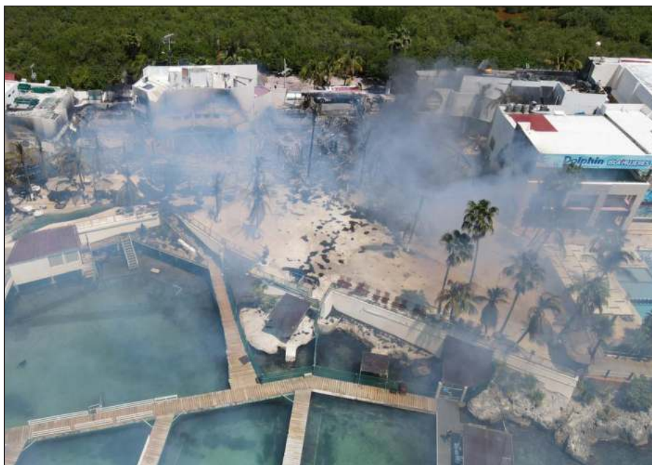
▲ La conflagración no dejó lesionados, y pese a que el fuego fue controlado, aún persistía un fuerte olor a gas debido a las fugas provocadas por el siniestro. Foto TV Isla Mujeres
