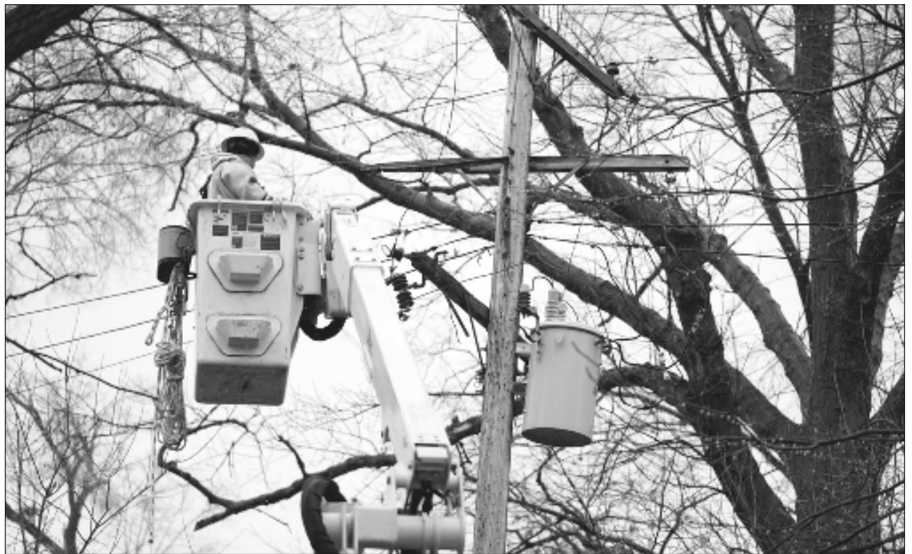
▲ La helada del miércoles cubrió los cables y árboles con al menos de 1.2 centímetros (media pulgada) de hielo. Después de la tormenta se registraron fuertes vientos que dejaron a más de 600 mil clientes de DTE sin luz. Foto Ap
