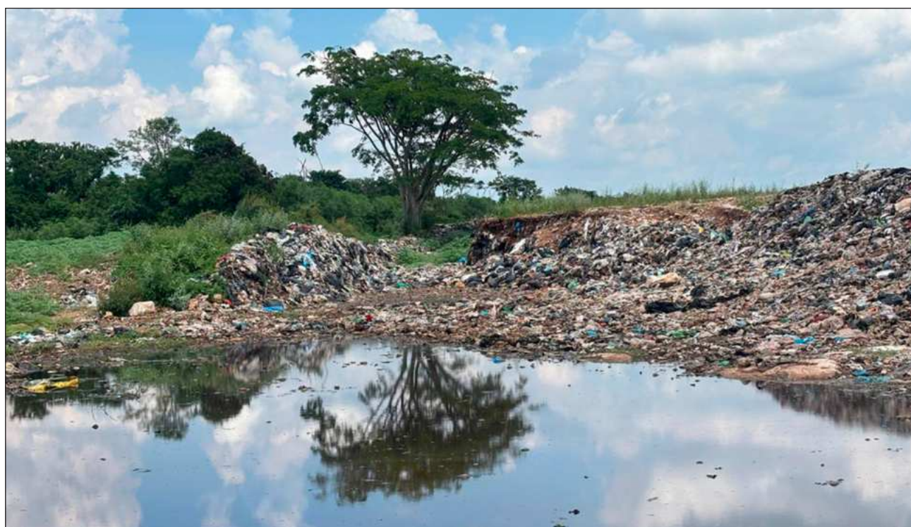
▲ La Profepa levantó el 20 de mayo la clausura total temporal que había impuesto al relleno desde octubre de 2025 después de verificar la conclusión de los trabajos para el sistema de captación, conducción y recirculación de lixiviados. Foto Profepa
