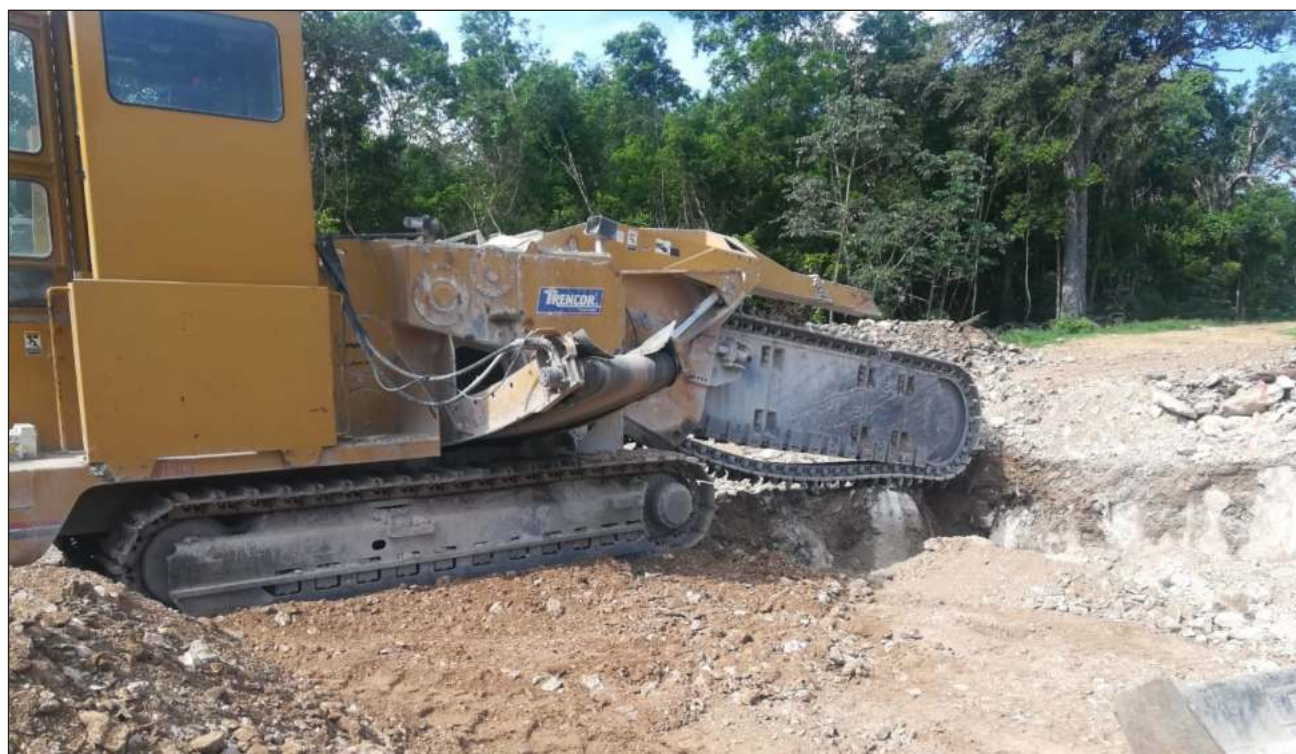
▲ El relleno sanitario del municipio tendrá una nueva celda emergente, con una superficie de 50x50 metros. Foto Miguel Améndola
