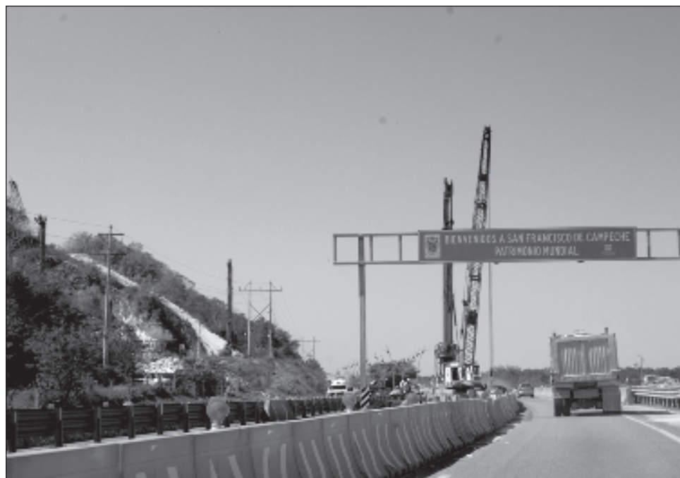
▲ “Las empresas no quieren responsabilizarse con los trabajadores y peor aún, los residentes de obra firman los reportes alegando que los accidentes son fuera del horario laboral y por ello las constructoras no indemnizan a los obreros”. Foto Fernando Eloy
