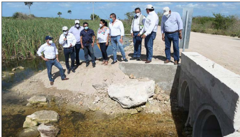
▲ El gobernador constató los trabajos de rehabilitación en la carretera que conecta a Panabá y San Felipe. Foto twitter@MauVila
