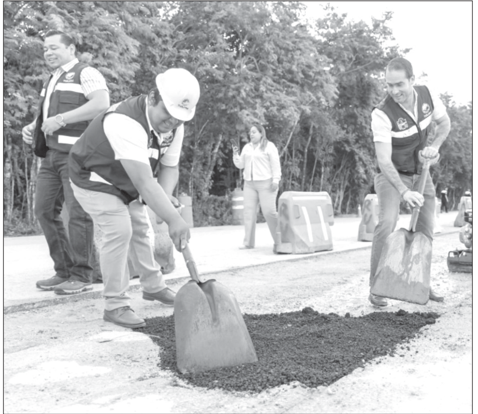
▲ Los trabajos serán divididos en cinco rubros: pavimentación; camellón central; ciclovía y jardineras; andador y cruces de acceso, y alumbrado público. Foto ayuntamiento de Tulum
