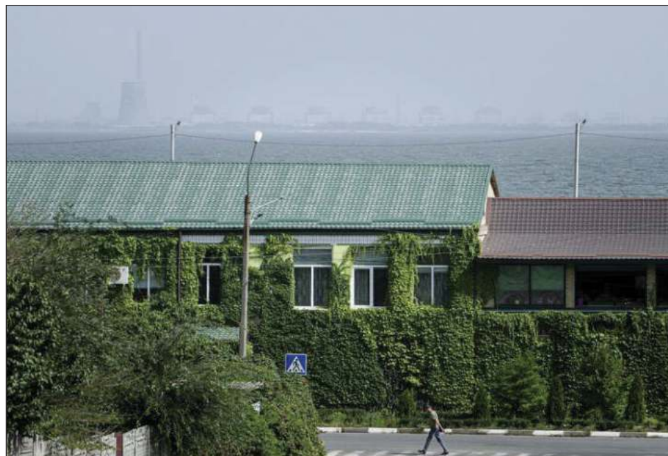
▲ los dos reactores que quedan en la planta nuclear -la más grande de Europa- están ahora sin electricidad, señaló la agencia Energoatom Foto Ap
