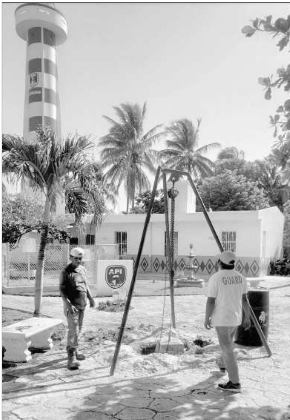
▲ Se trabaja en el mantenimiento general de la cúpula la cual tenía mucho de tiempo sin ser atendida. Foto Facebook API Campeche
