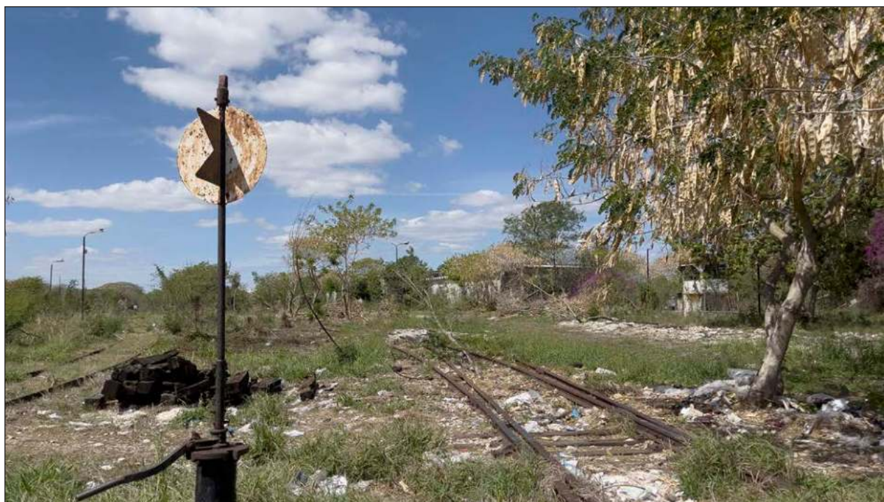
▲ Entre los caminos ferroviarios a rehabilitar se encuentran las que conectarían el Golfo con el Pacífico: de Coatzacoalcos, en Veracruz, a Salina Cruz, en el Istmo de Tehuantepec, Oaxaca; lo cual se terminaría este año. Foto jusaeri
