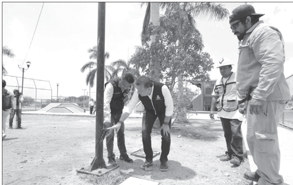
▲ El alcalde Alejandro Ruz Castro, detalló que “en esta ocasión nos estamos enfocando a los 27 espacios públicos donde funcionan normalmente algunos tianguis para verificar que todas las instalaciones eléctricas del ayuntamiento”. Foto ayuntamiento de Mérida
