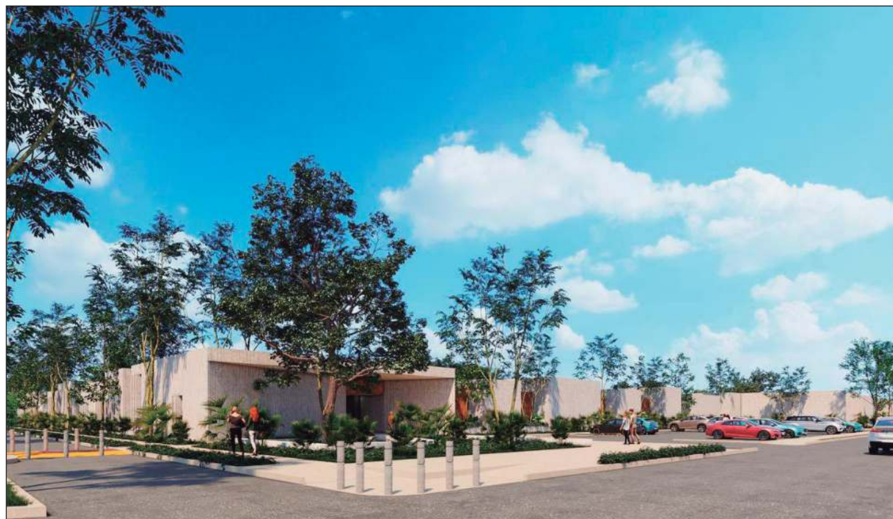
▲ Esta obra se realiza con una inversión de 153 millones de pesos y se prevé que esté terminada para finales de septiembre de este año para comenzar con el traslado de los menores, con la capacidad de albergar hasta 250 personas. Foto Gobierno de Yucatán
