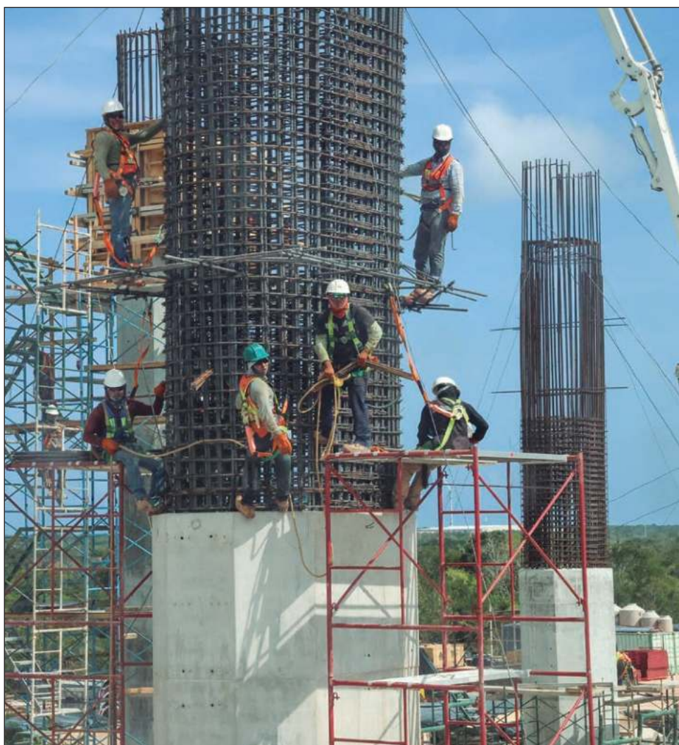
▲ En Quintana Roo se lleva a cabo el puente vehicular Nichupté que tendrá 8.8 kilómetros de extensión y contará con dos entronques de acceso. Foto Juan Manuel Valdivia
