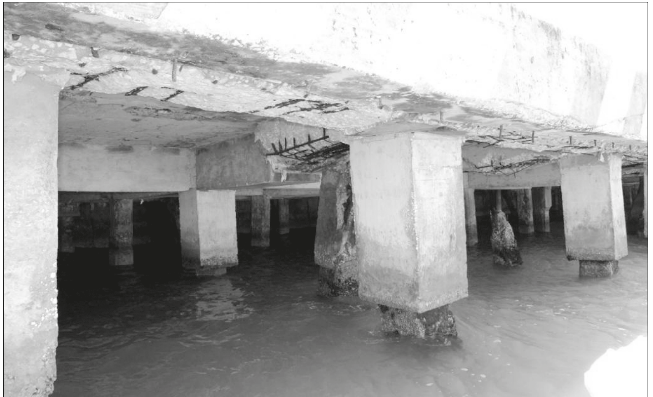
▲ Los pilotes fueron construidos en 2019 para sustituir a los anteriores, pero éstos nunca fueron retirados. Foto Gabriel Graniel
