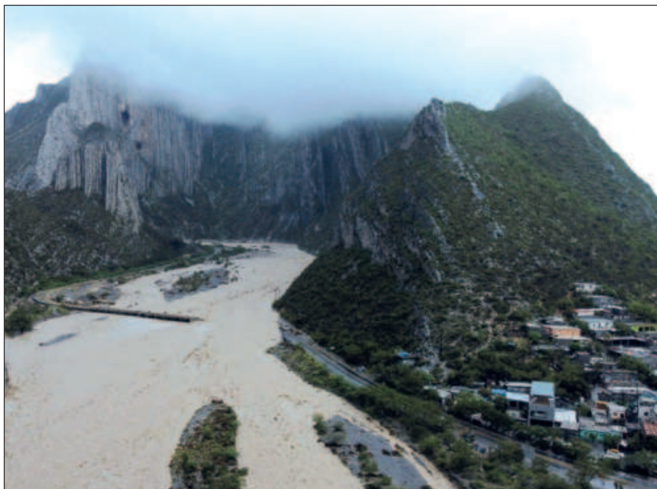
▲ El gobernador Samuel García Sepúlveda estimó que en una etapa inicial se requiere de al menos mil millones de pesos para reparar los daños dejados por el meteoro, al destacar la destrucción de caminos y carreteras rurales. Foto Reuters
