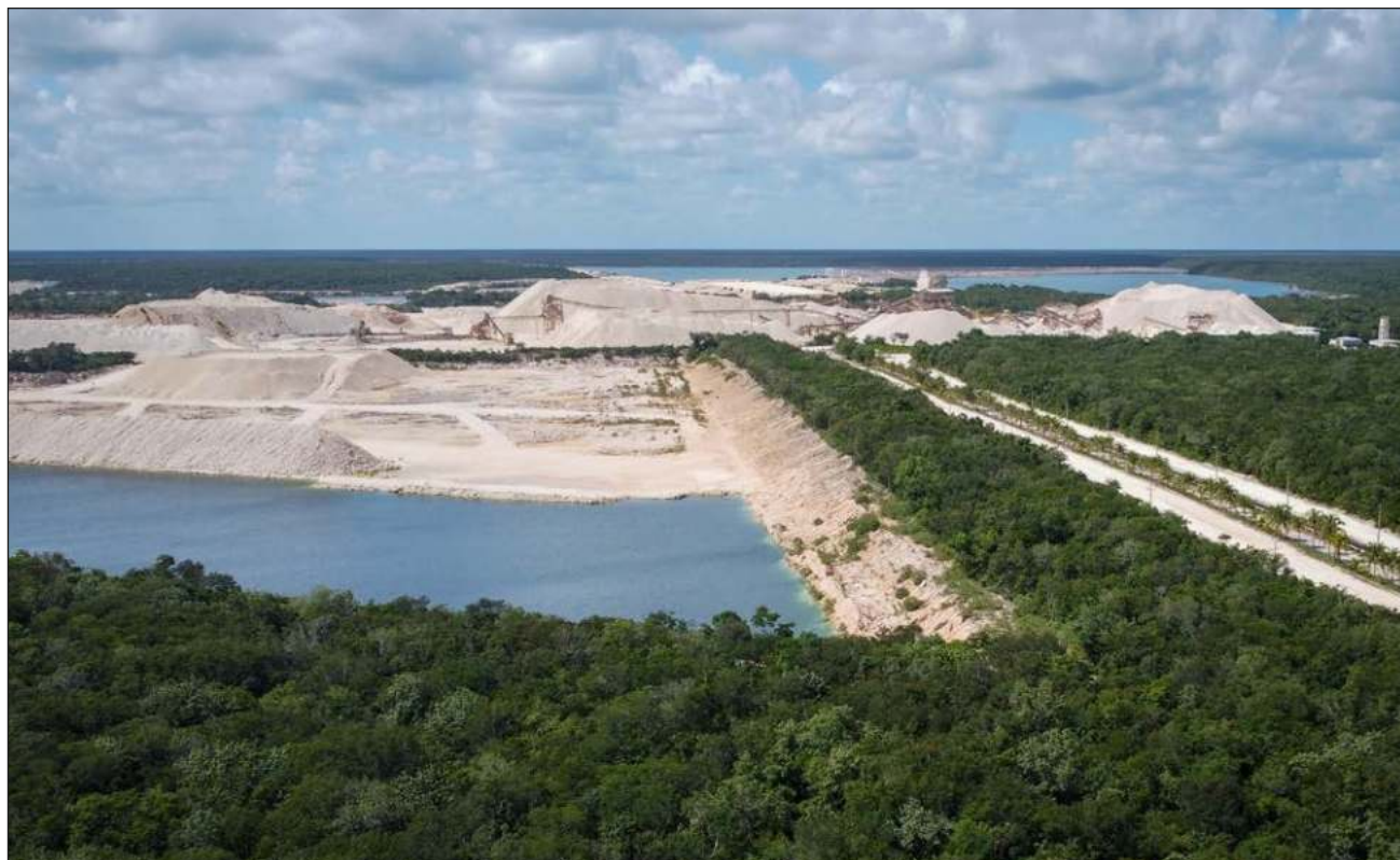
▲ La empresa extractora de material pétreo fue clausurada por la Profepa en mayo pasado, y se impusieron como medidas de seguridad las clausuras temporales totales de las actividades y obras realizadas en el sitio. Foto Juan Manuel Valdivia
