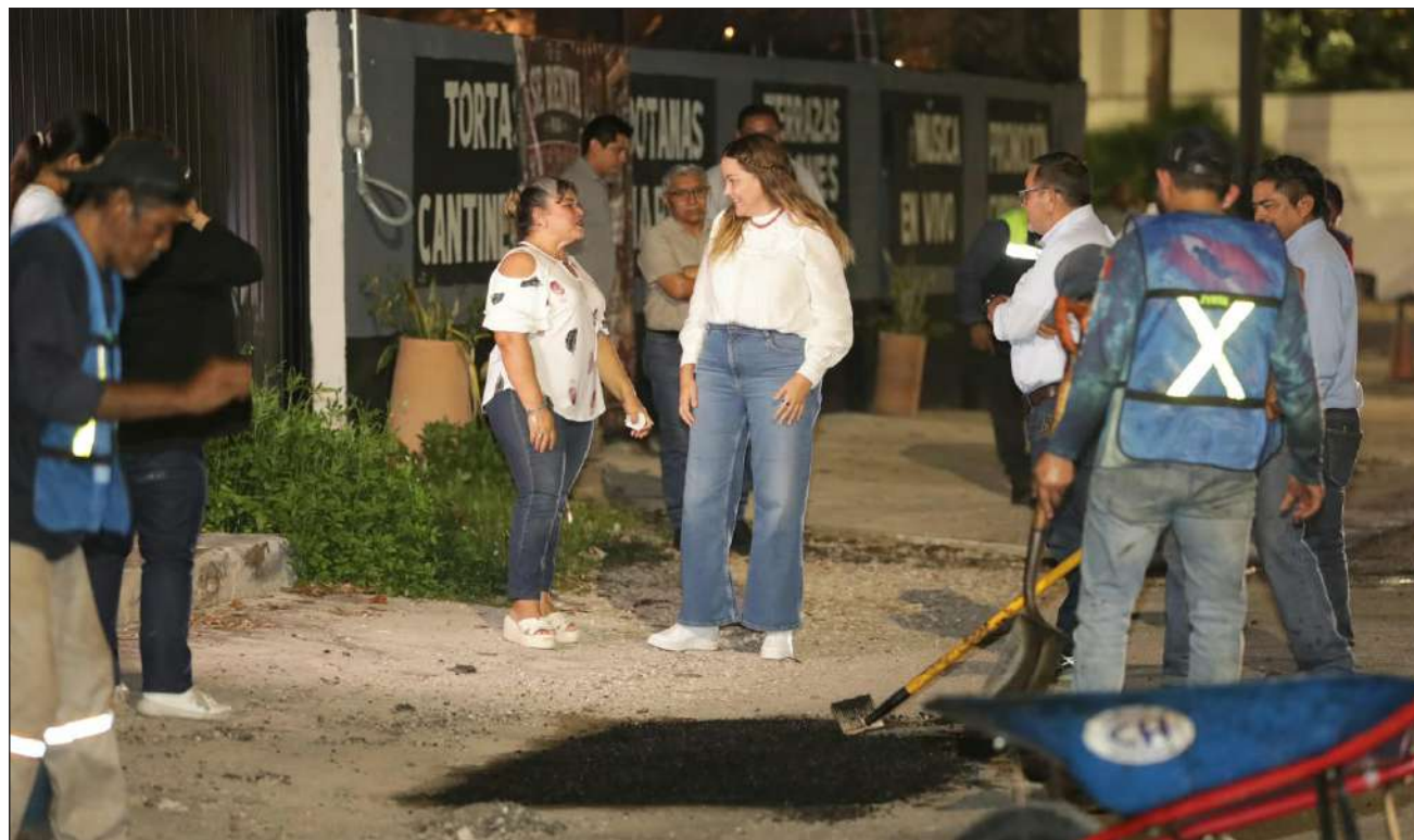
▲ Cecilia Patrón Laviada supervisó los trabajos de bacheo nocturno en la colonia Jesús Carranza. Foto ayuntamiento de Mérida
