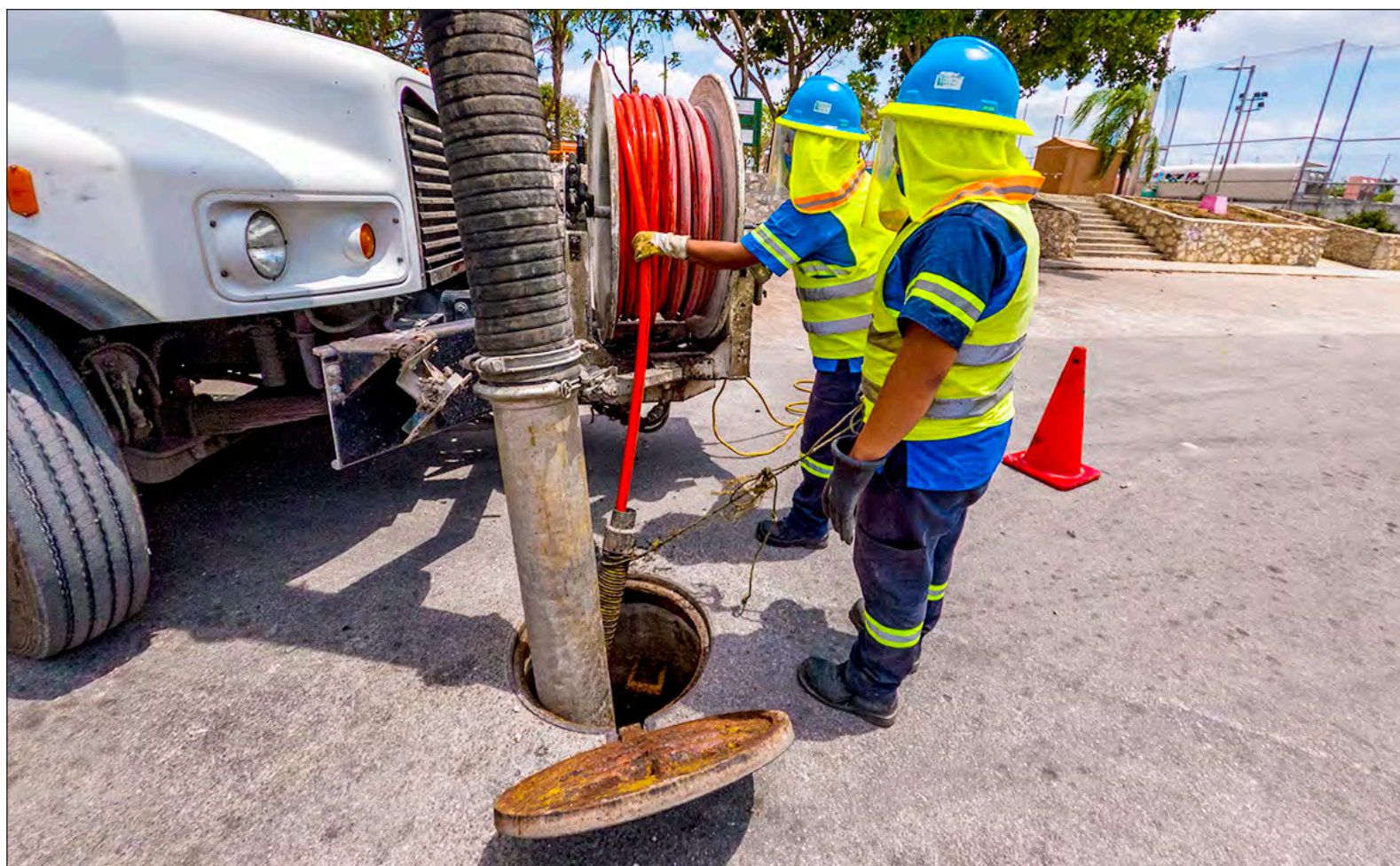
▲ Para que los hogares puedan hacer uso del agua, se requiere de un largo proceso: el vital líquido debe ser extraído, desinfectado, almacenado, distribuido al consumidor, recolectado, saneado y posteriormente reinyectado al manto freático. Foto Aguakan
