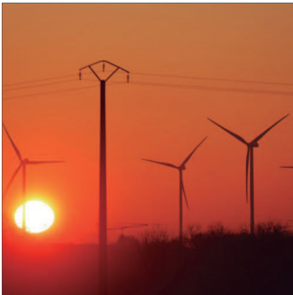
▲ El presidente estadounidense también indicó que la energía “no debería necesitar subsidios”, por lo que llamó a romper con lo que consideró una “locura”. Foto Reuters
