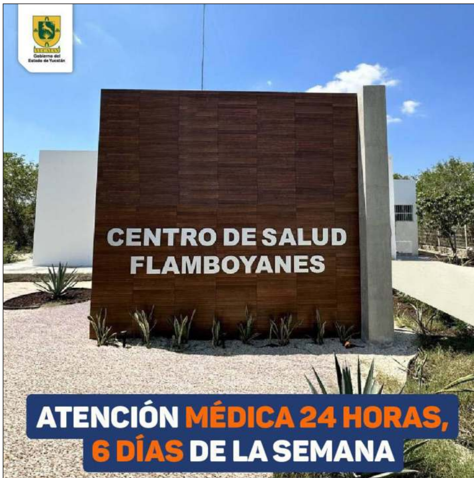
▲ Los trabajos de rehabilitación consistieron en construcción y equipamiento del consultorio dental dentro del terreno vigente, realizando labores complementarias que se requieran para conectar con el centro de salud actual. Foto gobierno de Yucatán
