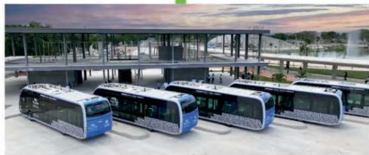
Se construye la estación del IETRAM en el Parque la Plancha, para 3 rutas de este transporte público 100% eléctrico y único en su tipo en Latinoamérica.
