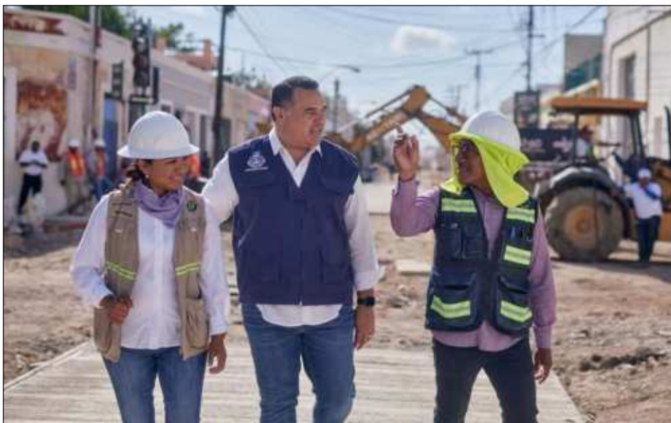
▲ El alcalde Renán Barrera explicó que ya se inició la instalación de los sistemas pluviales del Corredor Turístico Gastronómico de la calle 47, en donde personal de Obras Públicas coloca los canalones que servirán como sistema de drenaje pluvial. Foto ayuntamiento de Mérida
