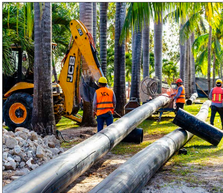
▲ Los trabajos dieron inicio en el primer trimestre del año. Foto Aguakan
