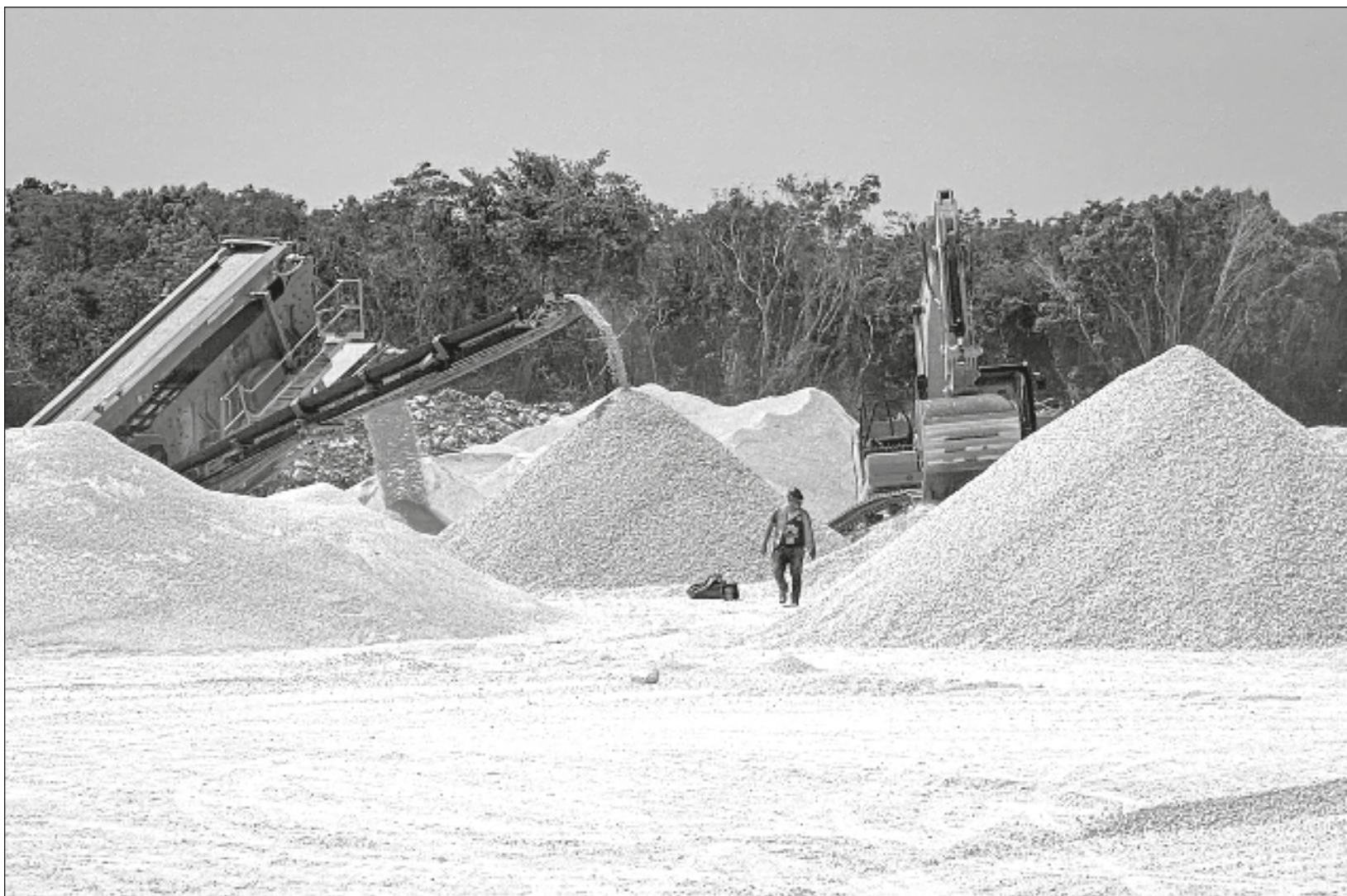
▲ “Están llegando muchos camiones de fuera y hay algunos detalles con los empresarios que se adjudicaron algunas obras y tratan de desestabilizar el orden que hay en el estado”, acusó el secretario general del sindicato de volqueteros de la CROC y representante de la unión de concesionarios del gremio. Foto Juan Manuel Valdivia
