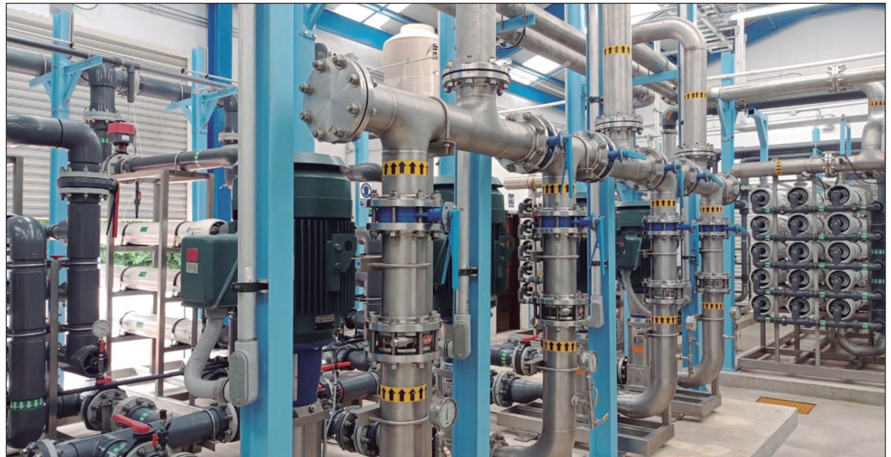
▲ La infraestructura permite producir agua de primera calidad mediante el empleo de la tecnología de ósmosis inversa. Foto Rosario Ruiz
