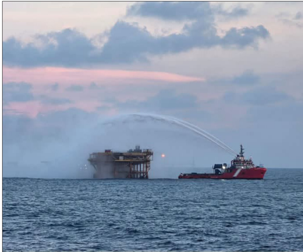
▲ El inicio fue a las 11:15 horas en la plataforma satélite, la cual se encuentra deshabitada. Foto Pemex
