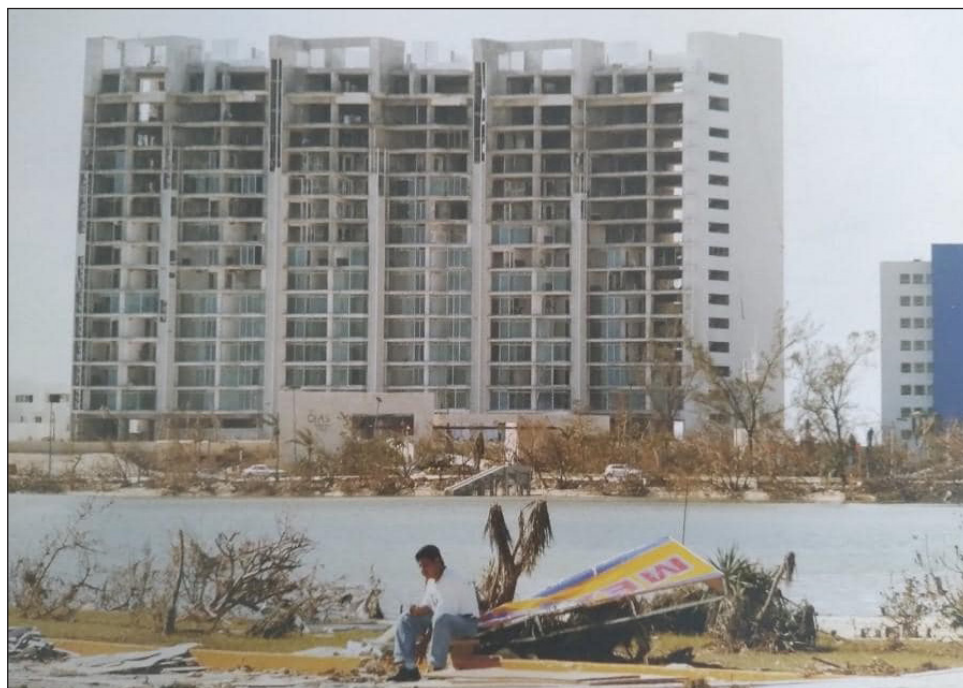
▲ Dos décadas después, los recuerdos siguen vivos: techos arrancados, calles convertidas en ríos, con colonias como la Donceles, en donde el agua subió más de seis metros, y algunos hoteles de la zona hotelera, que quedaron reducidos a esqueletos de concreto. Foto Facebook Mara Lezama
