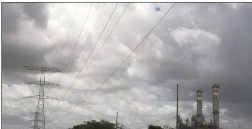
▲ Lo que se ignora al momento es si la CFE ya cuenta con planes de inversión, mantenimiento preventivo, fortalecimiento y modernización de la infraestructura instalada en la península. Foto jusaeri
