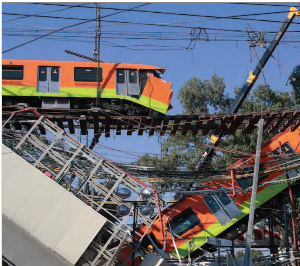
▲ En el desplome de la Línea 12, el 4 de mayo de 2021, murieron 24 personas. Foto Luis Castillo
