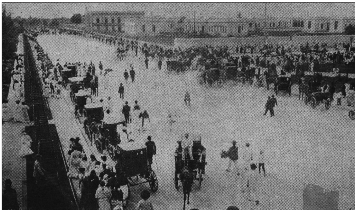
▲ “La transformación de Mérida requirió dinero y en grandes cantidades, y el gobierno de Olegario Molina concibió que la inversión necesaria tendría como eje la higiene: pavimentación y pozos pluviales para disminuir la presencia de mosquitos y otras plagas”. Foto El Tiempo Ilustrado, 18 de febrero de 1906
