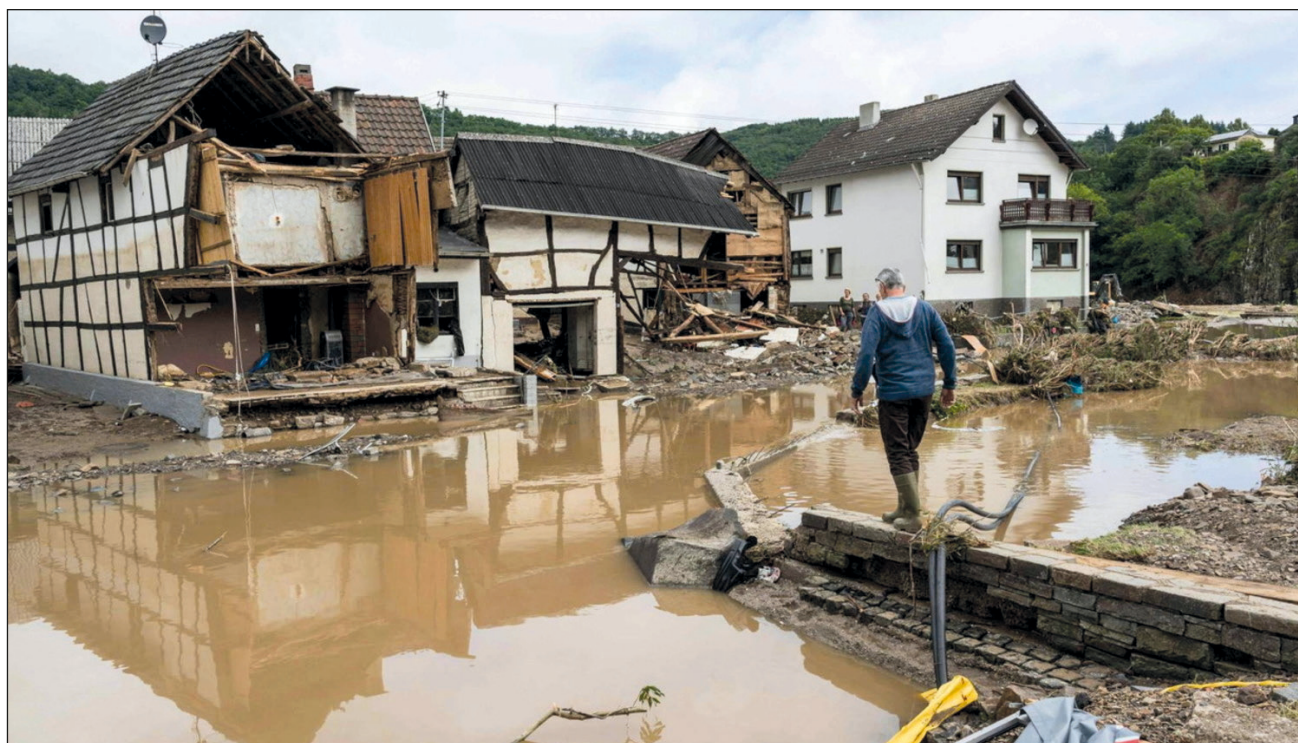
▲ La protección civil alemana no avisó lo suficientemente rápido a la población residente en zonas inundables ante la gravedad de las crecidas. Foto Afp
