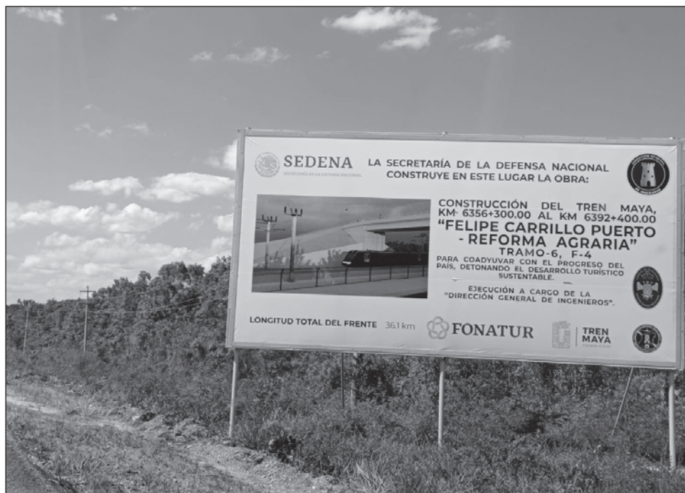
▲ Más de 7 mil trabajadores construyen el tramo 6, que va de Tulum a Chetumal por 255.8 kilómetros y registra un avance de casi 24 por ciento. Foto Rosario Ruiz
