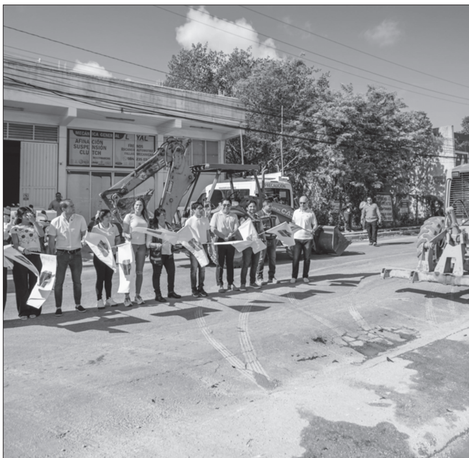
▲ La obra beneficiará a más de 50 mil habitantes del municipio. Foto ayuntamiento de Tulum
