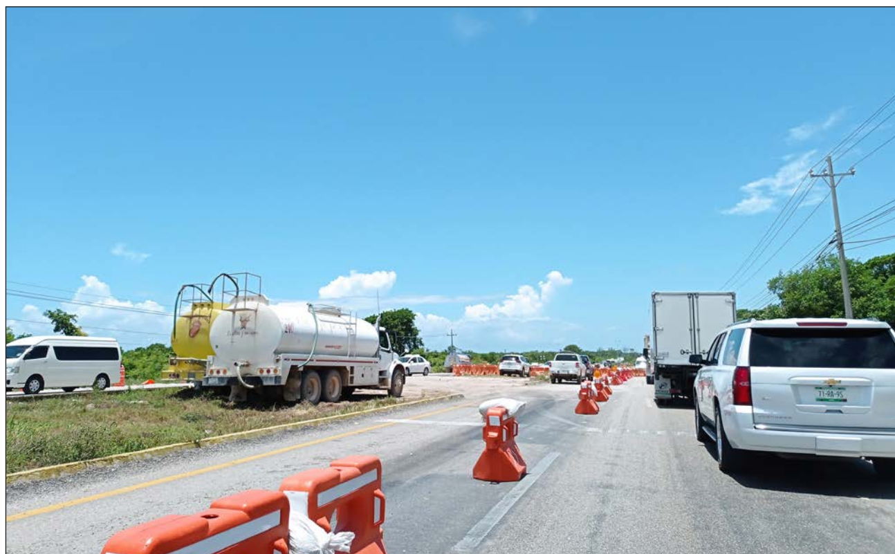
▲ Los trabajos son llevados a cabo por la empresa Acciona y Grupo e incluyen topografía, mecánica de suelos y levantamiento de la carpeta asfáltica. Foto Rosario Ruiz
