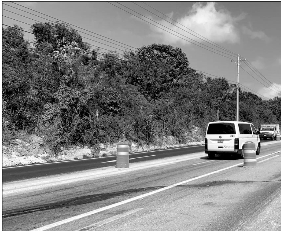
▲ En el kilómetro 307+650 de esta carretera federal, se presentó un agrietamiento en la superficie; el desvío consiste en un carril de 400 metros de longitud por 4 de ancho, para una doble circulación. Foto Fonatur
